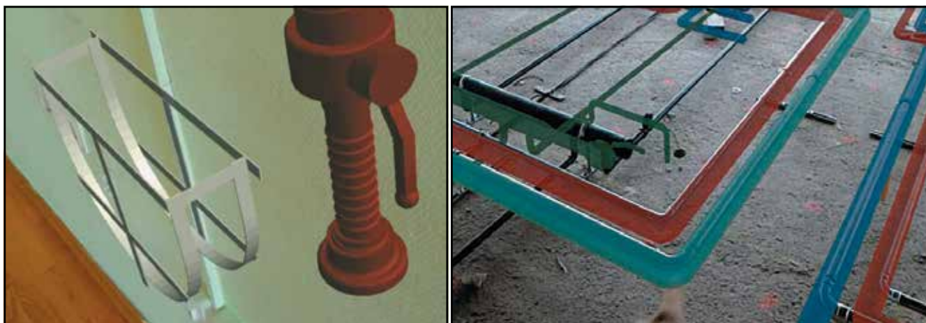
Рис. 2. Примеры выявления коллизий и несоответствий при наложении виртуальных данных, выгруженных из теоретической трехмерной модели и наложенных на реальное окружение помещений
