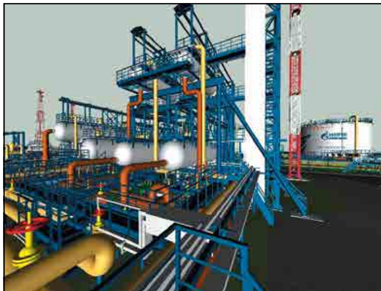
Рис. 2. ПРИМ Новопортовского месторождения. На первом плане – технологическая установка ЦПС (1-ая очередь строительства)
