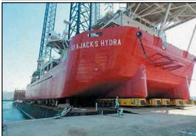
Строительство мобильной платформы с выдвигаемыми опорами Seajacks Hydra
