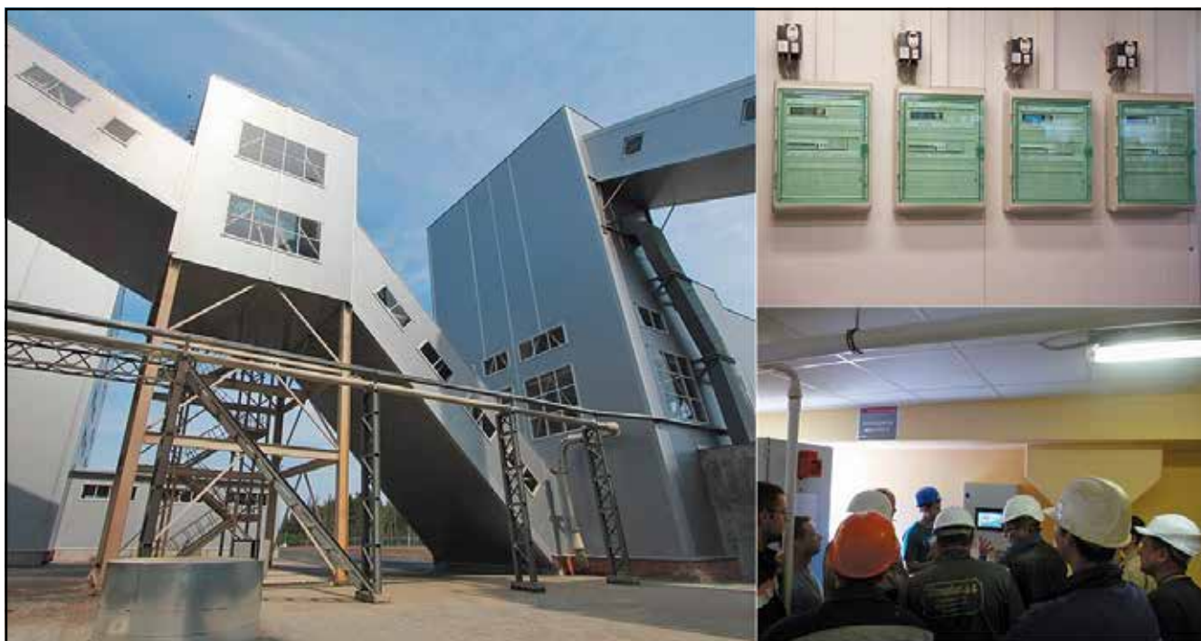
Рис. 6. Фото с объекта автоматизации – деревообрабатывающего комбината “Калевала”
