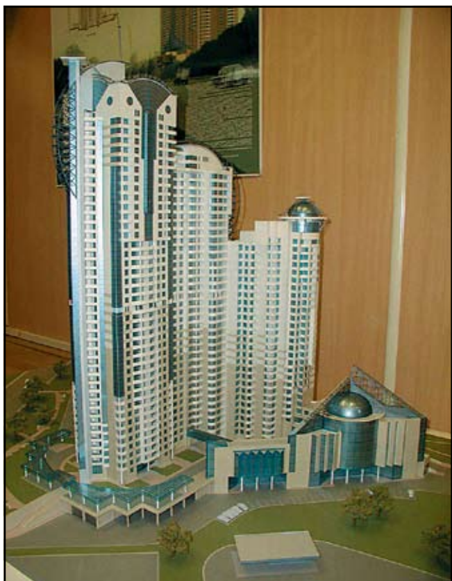
Рис. 1. Многофункциональный высотный комплекс “Вертикаль”: H_{max} = 120 м, среднее давление под подошвой фундаментной плиты – 10 \text{ кг/см}^2
